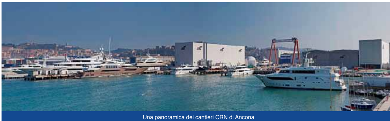
Una panoramica dei cantieri CRN di Ancona
